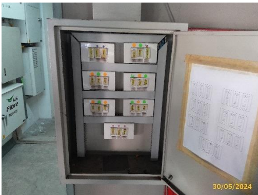
แยกสวิตช์ควบคุมอุปกรณ์ไฟฟ้าแสงสว่าง
