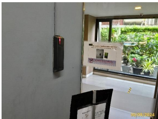
ระบบคีย์การ์ดเข้า-ออก อาคาร และลิฟต์โดยสารระบุตัวตน
