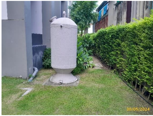
ระบบกำจัด Aerosol และระบบกำจัดมีเทน อาคาร C
