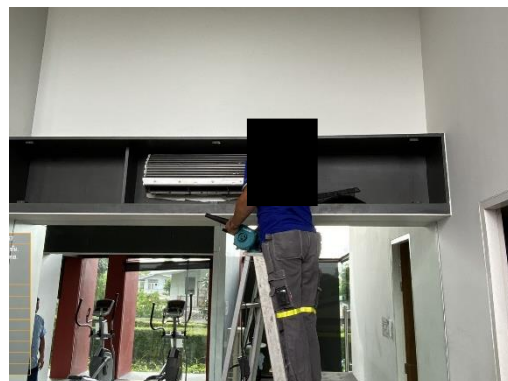
การทำความสะอาดเครื่องปรับอากาศส่วนกลาง
